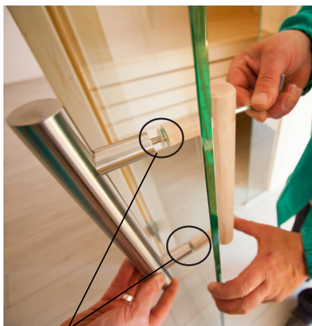
Applicare rondelle di plastica nelle maniglie Nirosta
