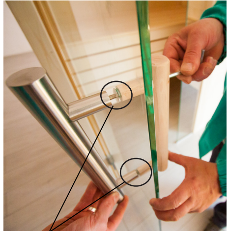
Kunststoff Beilagscheibe bei Niro-Griff beilegen
