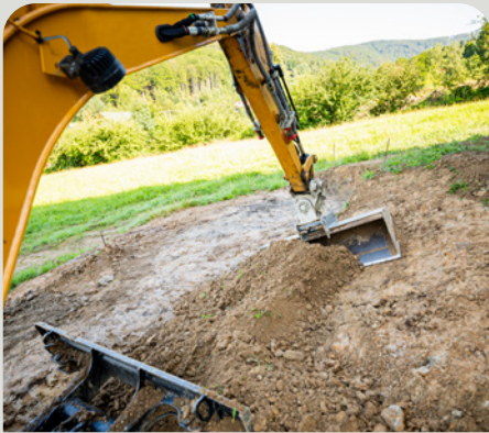
1. Dig the Tunnel
