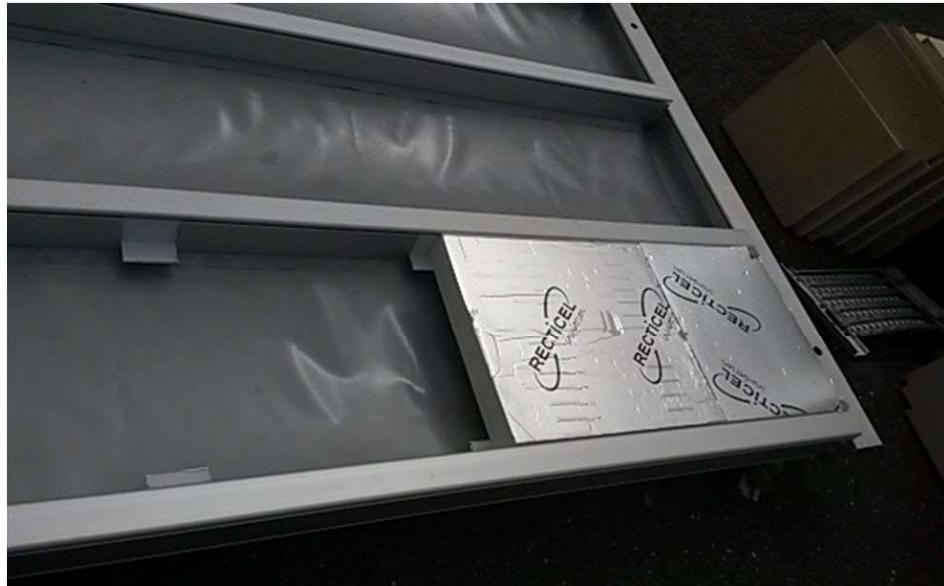
Les plaques d'extrême de chacune des travées sont également coupées à la bonne longueur, et peuvent aussi nécessiter une recoupe pour le passage des écrous.
