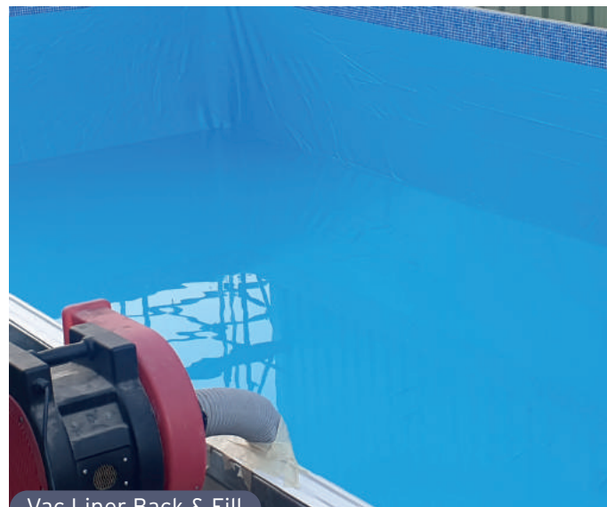
Vac Liner Back & Fill
